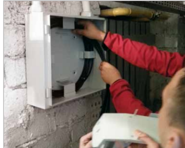
Fot. 2. Prace nad organizacją kabli zewnętrznych w MICRO POINT (piwnica)
