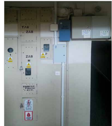
Fot. 5. Zdjęcie zakończonych prac – klatka schodowa
