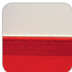
maskowanie na ścianie
