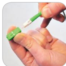
montaż obudowy SC/APC na złączu SC2
