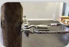
Przykład montażu TwistAIRa do Combo
